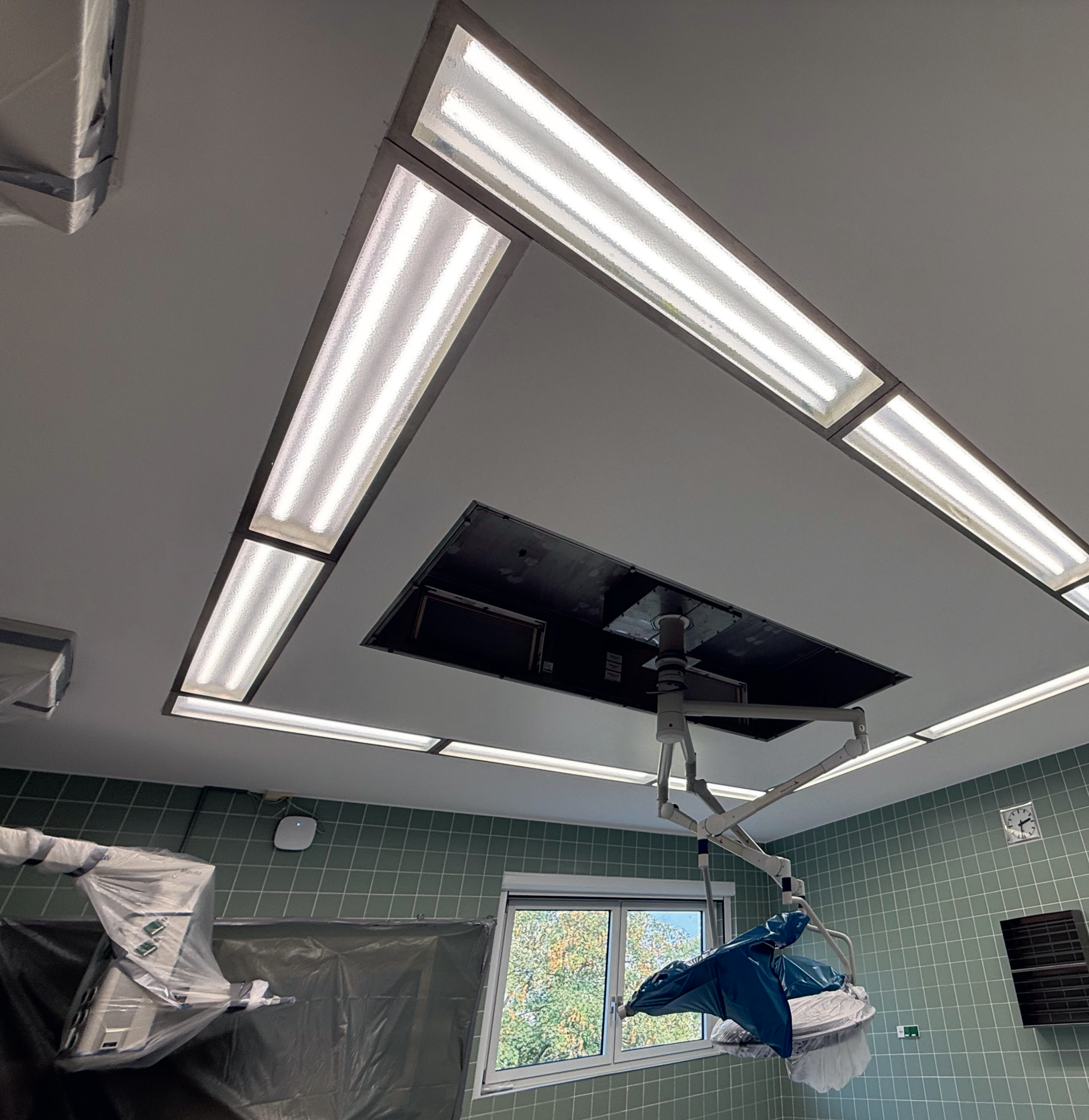
Abbildung 1: Der OP-Saal nach seiner Licht-Sanierung: Für den Umbau waren alle wichtigen Komponenten des Raumes abgedeckt und vor Staub oder anderem Schmutz geschützt.
