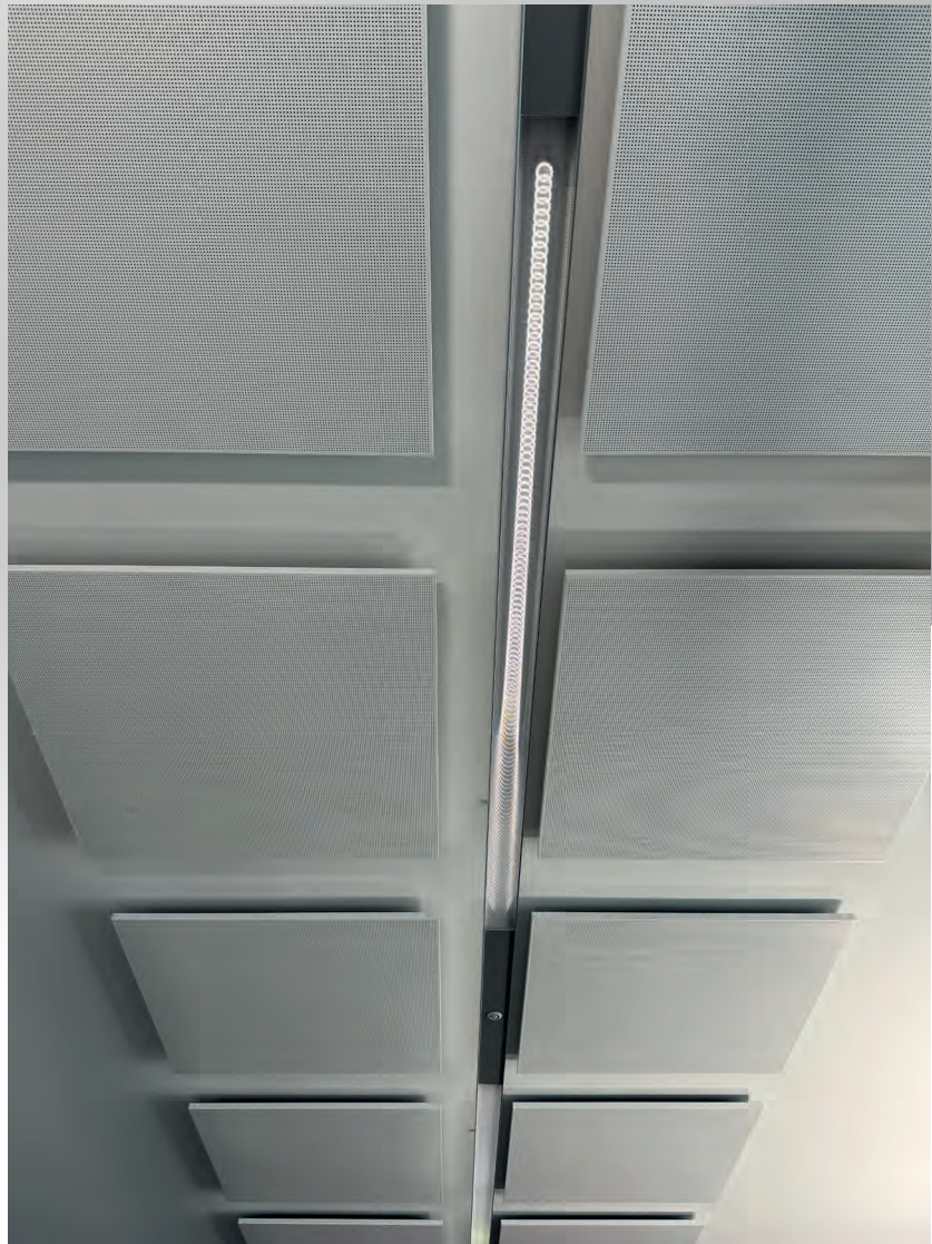
LL1-Lichtlinie, stark gedimmt durch Tageslichtsensorik
