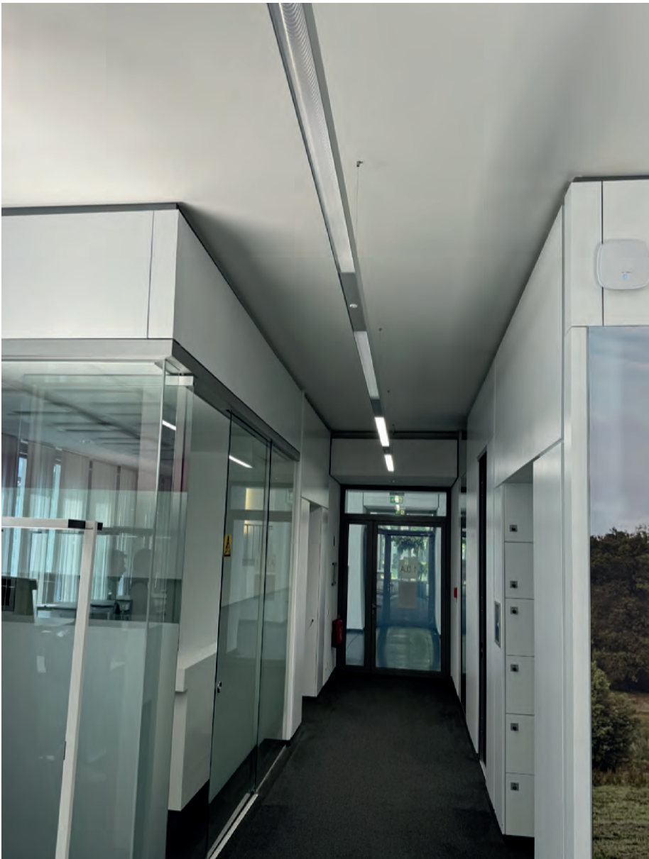
LL1-Lichtlinie mit gerade aktiver Tageslichtsensorik.
