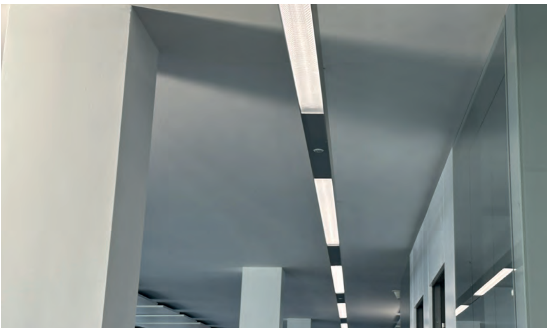
LL1-Lichtlinie mit gerade aktiver Tageslichtsensorik.
